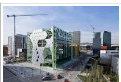
Edificio Media TIC en Barcelona
